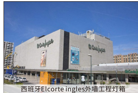
西班牙Elcorte ingles外墙工程灯箱
